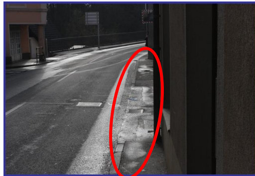
Nevarni pločniki na državni cesti
